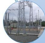
Dotación de un punto de entrega de potencia y energía eléctrica del S.N.I. al Cantón Quinindé a través la S/E CELEC EP TRANSELECTRIC con 2 líneas de Subtransmisión a nivel de 69 kV .
