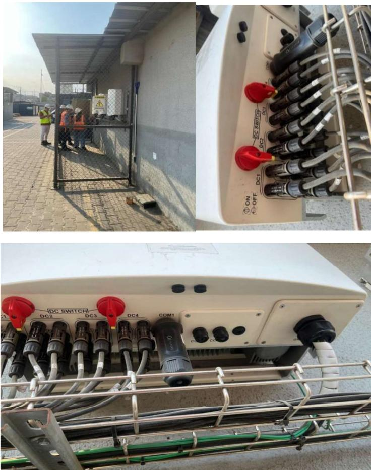
4.111 Colocar señales de Peligro en CC y CA, en las canaletas, tableros, cajas de conexión y tuberías, como se demuestra en la siguiente figura:
