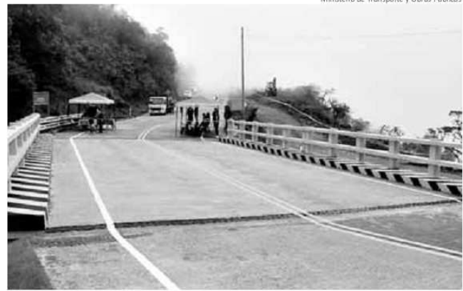
→El puente se ubica en la vía Paute-Guarumales-Méndez, donde está el principal complejo hidroeléctrico del Austro.
