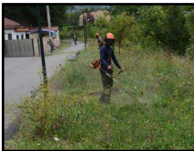
Figura 17. Ejemplo de Desbroce de Vegetación y Limpieza
