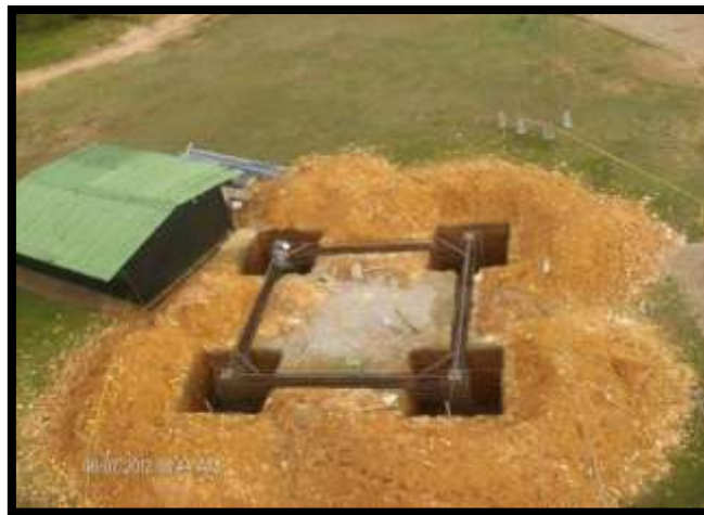
Figura 19. Cimentación Tipo para Torres
