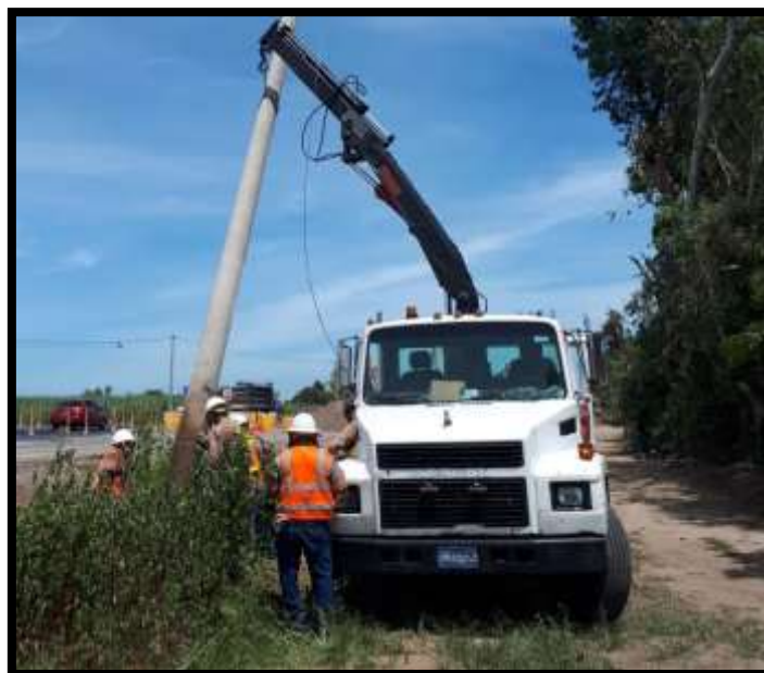
Figura 22. Montaje de poste
