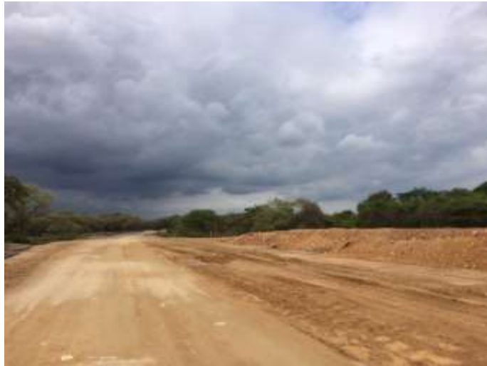
Construcción de nueva vía que conecta la vía Durán-Bolicho y vía Durán-Tambo
