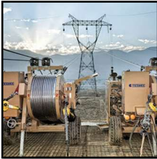
Figura 25. Templado de Conductores
