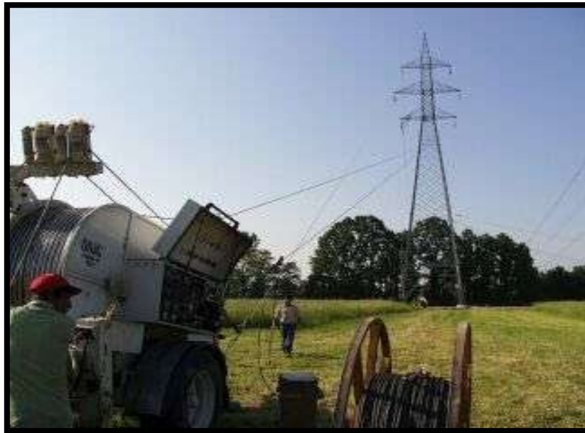
Figura 24. Tendido de Conductores de Fase
