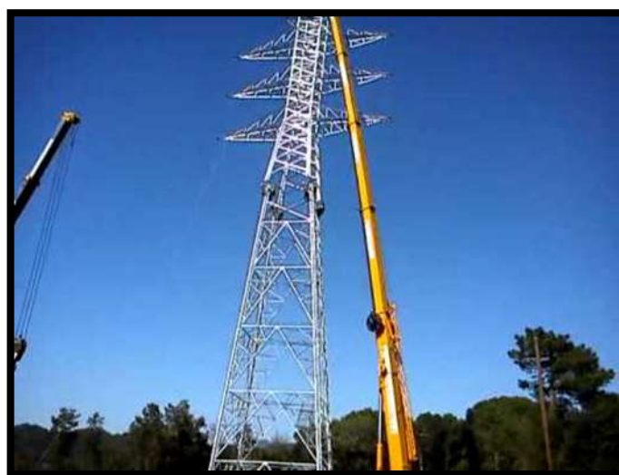
Figura 21. Montaje de Torres
