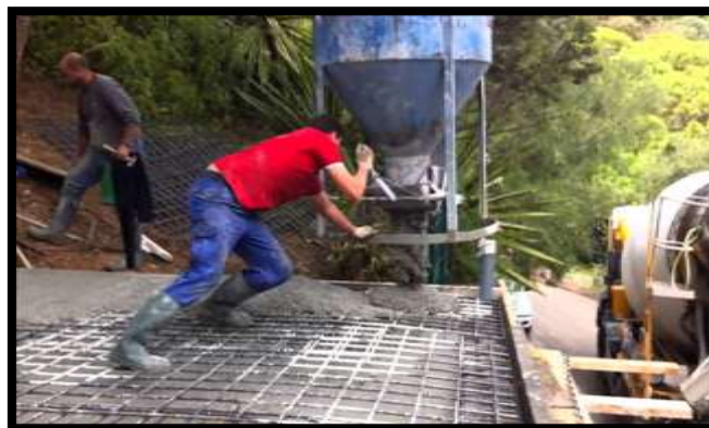
Figura 20. Vertido de Hormigón
